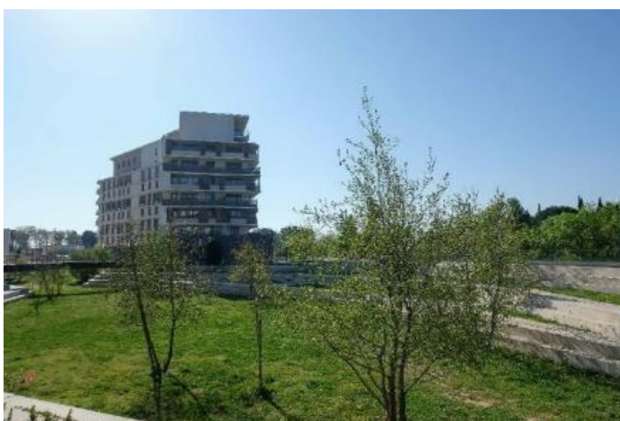
Fotografia 64. Zbiornik retencyjny (suchy) (Montpellier)
